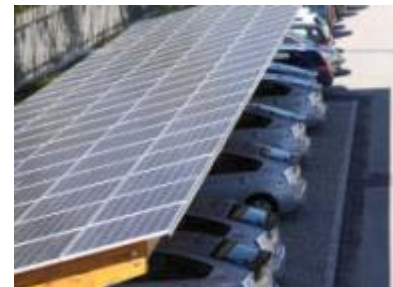
Plate-forme "mobilité solaire"
